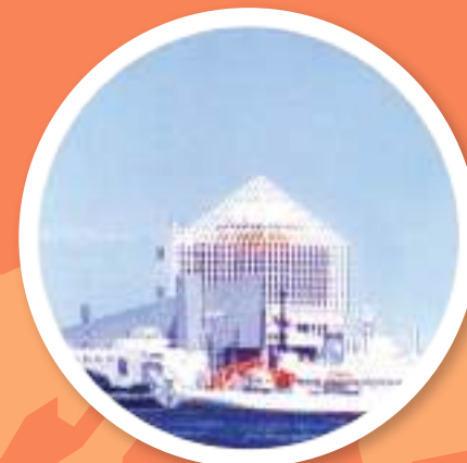
東京晴海客船站大樓 Harumi Passenger Terminal Building, Tokyo, Japan
