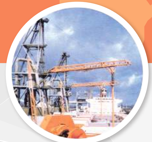
澳洲卸穀機 Ship Unloader, Australia
