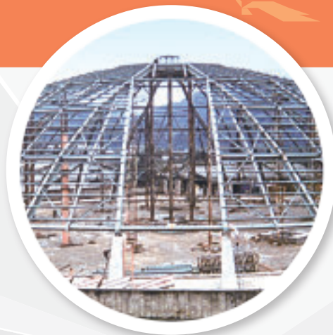
印尼水泥廠石灰石圓形倉庫 Indocement Circular Limestone Storage
